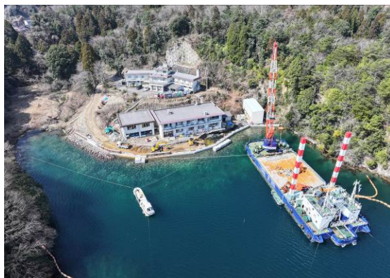
護岸復旧工事・基礎捨石投入完了（R8. 3. 17）
