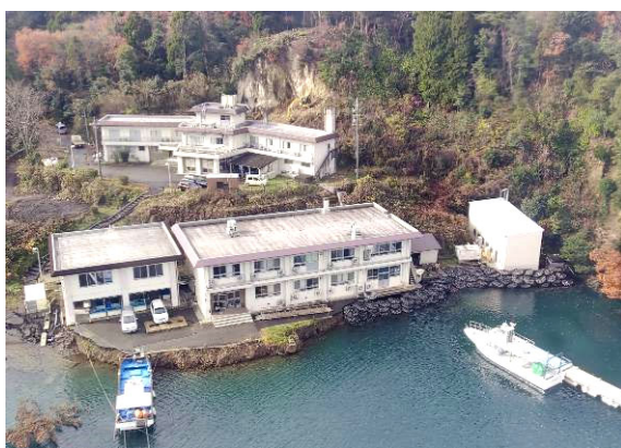
護岸復旧工事・二次災害防止対策（基礎 地盤浸食防護）完了（R6. 11. 28）
