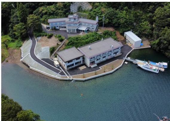
護岸復旧工事・完成（R8. 8. 31）
