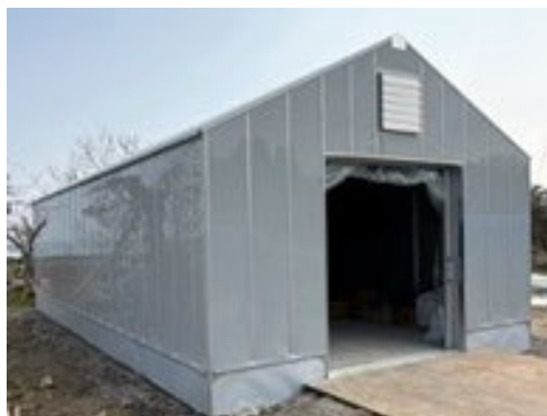
珠洲市の実証地に導入した CO 2 電解装置建屋
