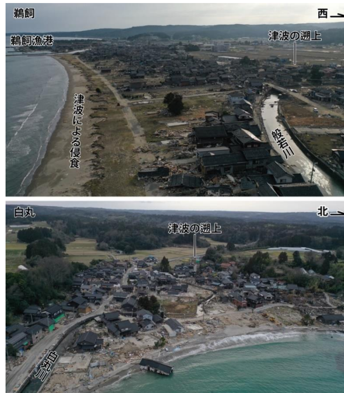
図2 珠洲市鵜飼と能登町白丸における津波被害の写真
