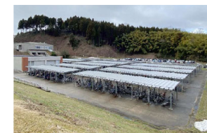
【既設駐輪場上屋への太陽電池パネル設置229KW】
