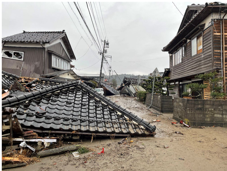
建物の倒壊状況
