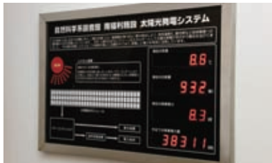
自然科学研究棟の屋上には太陽光発電システムを設置。案内パネルには日射量や発電量が表示される
