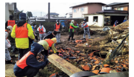
手渡しでがれきを撤去(長野市)
