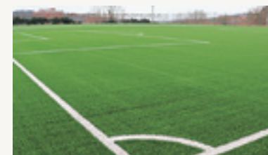
整備中のサッカー場
