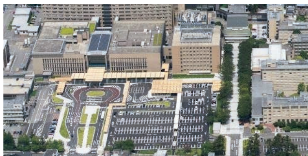
附属病院 駐車場、屋外通路
