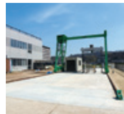
大型構造物載荷試験装置
