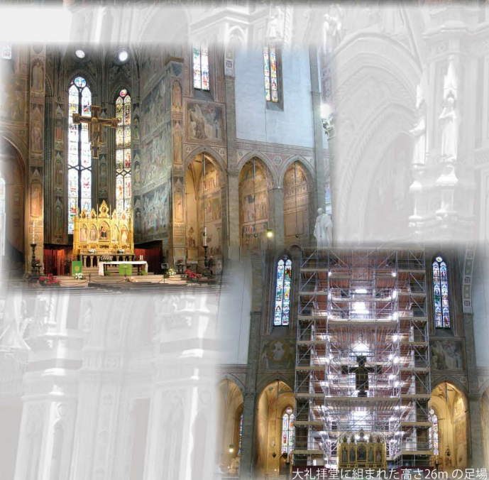
大礼拝堂に組まれた高さ26mの足場
