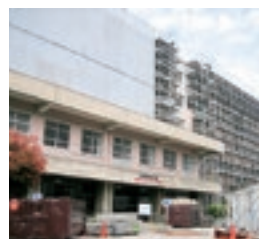
改修工事中の保健学類1号館
