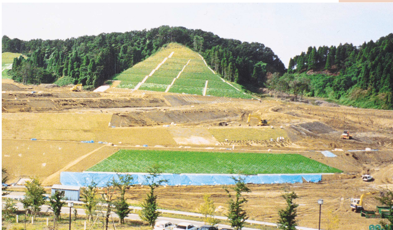
本部棟5階学長室から見た南地区工事現場（平成12年10月6日，林勇二郎学長撮影）[4頁に関連記事]
