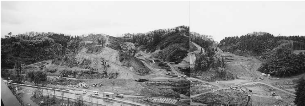
平成11年11月 樹木の伐採すすむ。（施設部撮影）
