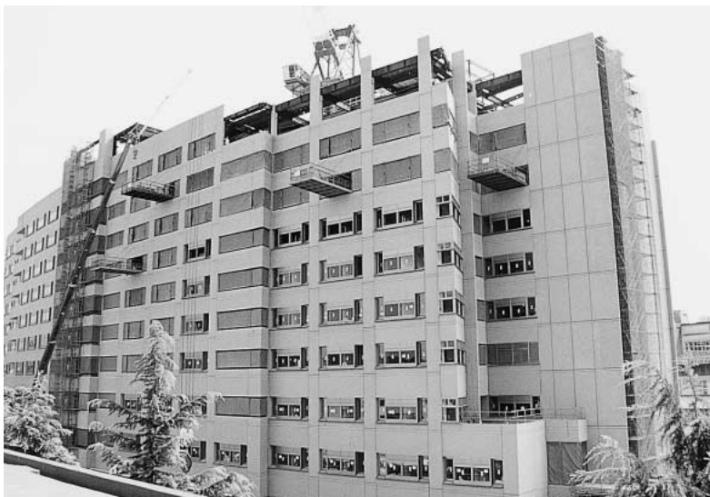
工事中の医学部附属病院（平成12年8月現在）
