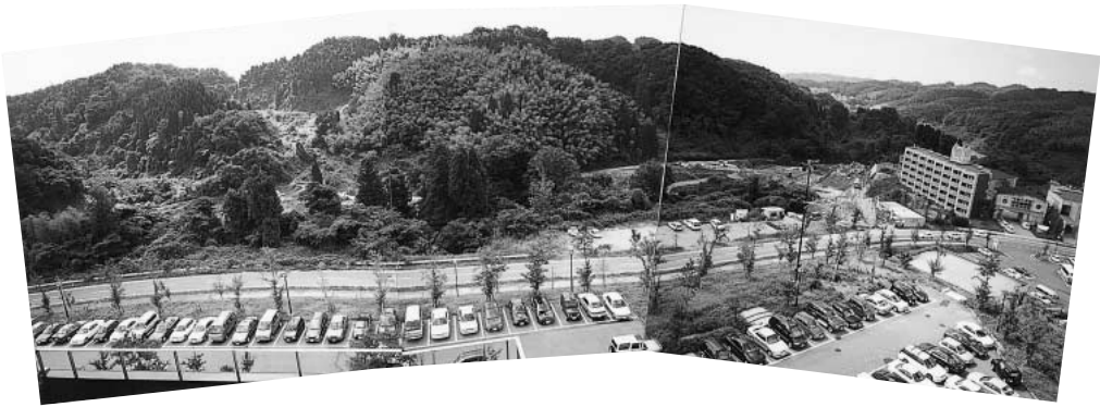
平成10年8月 工事をはじめた頃、山はそのまま。（施設部撮影）
