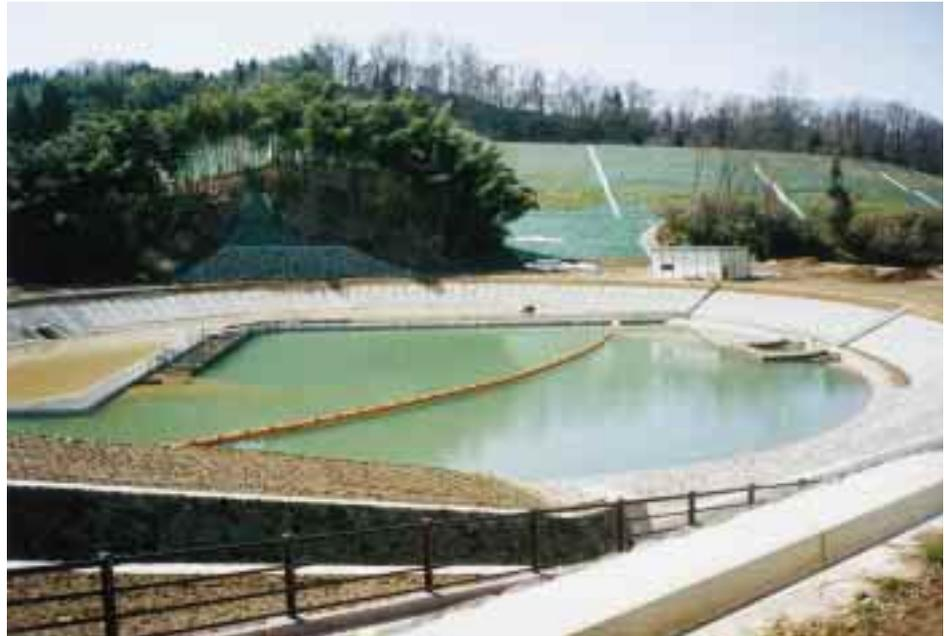
濁水(写真左方)が清水(写真右方)に変換
