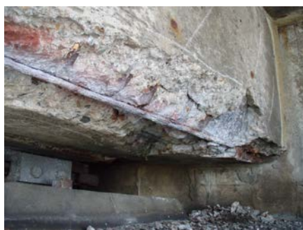
写真-1 凍結防止剤による塩害劣化 写真-2 アルカリ骨材反応による劣化
