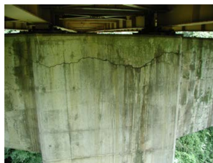
写真-1 凍結防止剤による塩害劣化 写真-2 アルカリ骨材反応による劣化
