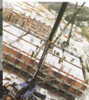
雪にかかわらず続行された工事 ＝平成7年12月撮影
